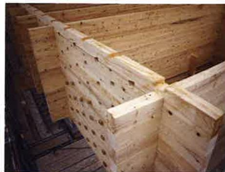
^ Pose de la toiture, montage du premier rang de poutre. Le montage est réalisé simultanément sur toute la surface du bâtiment. La moindre imprécision rendrait l'assemblage global impossible.
