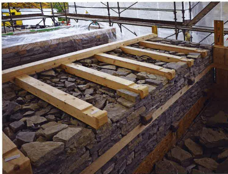
^ En haut : les poutres de rive et de chaînage stabilisent les ouvrages en pierre sèche.
